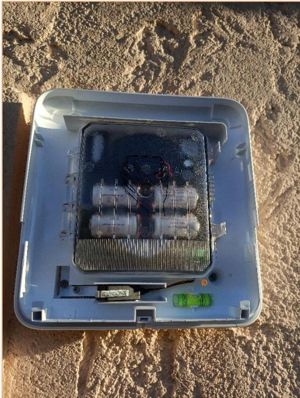
Positionnez la sirène à l'endroit désiré et tracez l'emplacement pour les vis.
