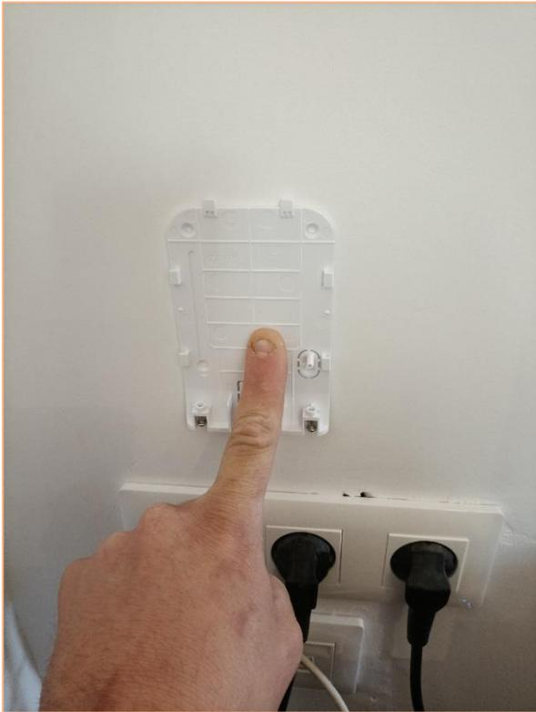
Positionnez la centrale à l'endroit désiré et tracez l'emplacement pour les vis.
