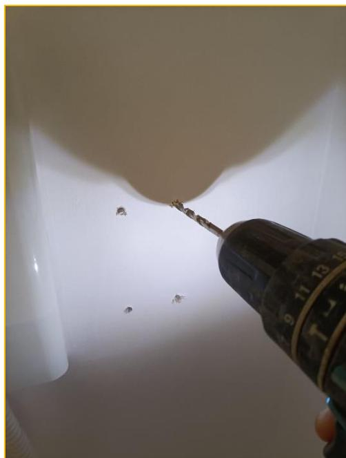
Faites un trou de 6mm de diamètre sur les marquages tracés.
