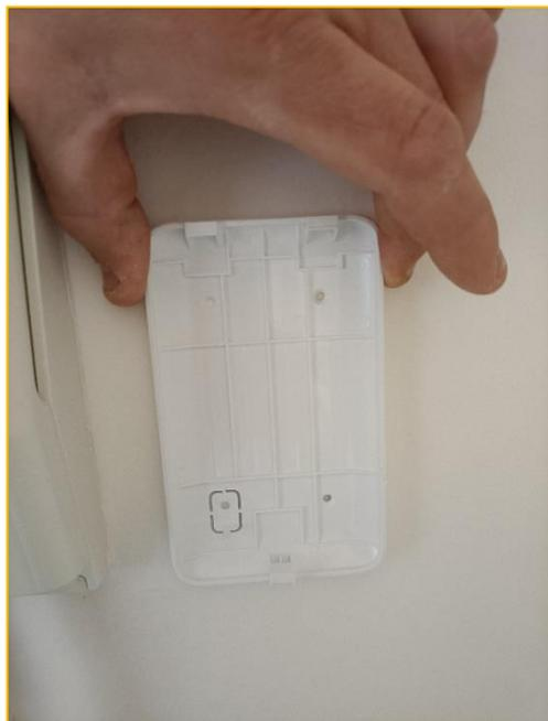
Positionnez le clavier à l'endroit désiré et tracez l'emplacement pour les vis.
