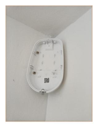
Faites un trou de 6mm de diamètre sur les marquages tracés, mettez les chevilles fournies avec le détecteur et fixez le détecteur avec les vis fournies.
